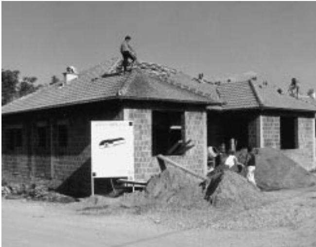
Bau des Familiengesundheitszentrums in Pirane
